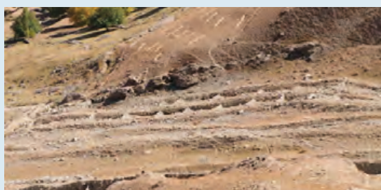
Barrages de retenue, digues de terre et plantations d'arbres visant à stabiliser les pentes
